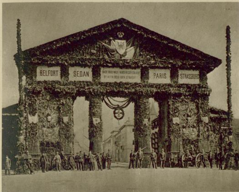
Abb. 5. Das Ettlinger Tor in Karlsruhe.
