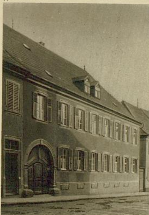
Abb. 115: Das Haus Huttenstraße Nr. 37 in Bruchsal, in welchem Staatsrat C. J. Oehl gewohnt hat.
