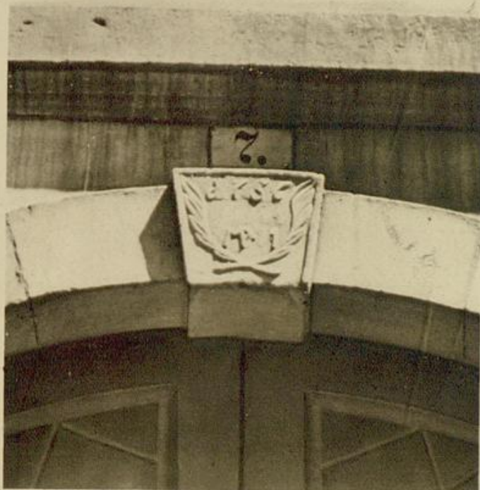
Abb. 100: Schlussstein des Hauses Waldhornstraße Nr. 7
