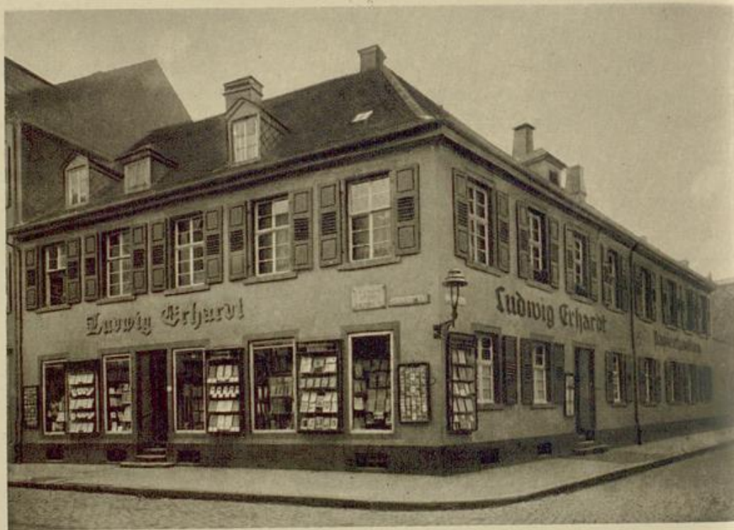
Abb. 68: Das Haus Erbprinzenstraße Nr. 27 erb. 1805 von Bau Conducteur Mesmer
