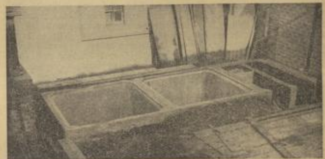
Verlängerter, mit Veranschlagung gebauter Walfutterbehälter für Grünfutter nach annehmlichem Kartoffelgarbehälter. Man beachte die außerordentlich günstige Bauausführung. (Autn.: Schmidt)
