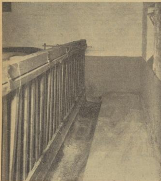
Durch das Frechhüter kann der Futtergang vom Stall abgeschlossen werden, so daß sich vor jeder Fütterung eine zuverlässige Reinigung der Krippe und des Futterganges durchführen läßt. Ebenso ist Leistungsfütterung möglich.
