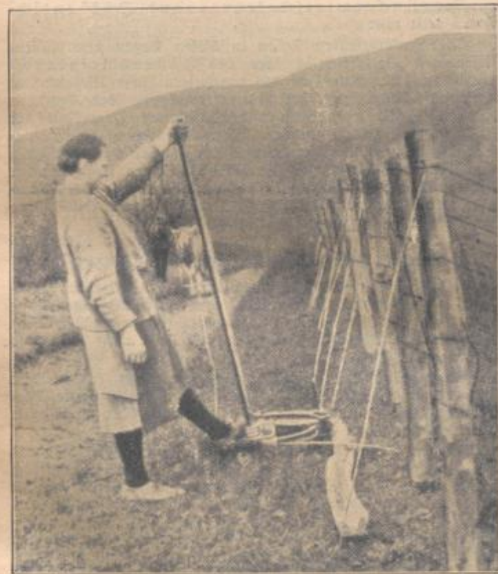
Seilzug aus einem alten Göppelrad zum Pflügen der Weinberge
