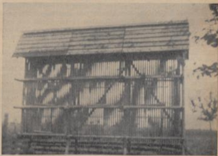
Der ideale Aufbewahrungsort für den Körnermais ist und bleibt der Trockenschuppen. Für kleinere und mittlere Betriebe ist der bayerische Weidenschuppen von Prof. Künzel-Nieder zu empfehlen, der etwa 100 Zentner erntereife Kolben faßt
