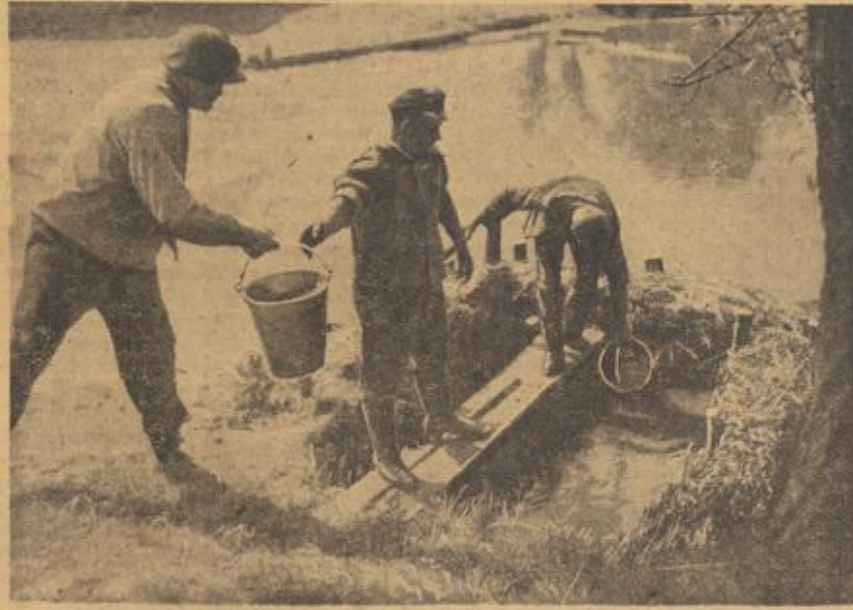
Wasser ist beim Luftschutz die Hauptsache! Der Löschteich des Dorfes ist mit Strauchwerk gegen Verschlämmung und Verschmutzung geschützt. Eine so vorbereitete Wasserentnahmestelle erleichtert der Eimerkette im Notfall die Arbeit. Aufnahme: Reichsnährstand/Limberg
