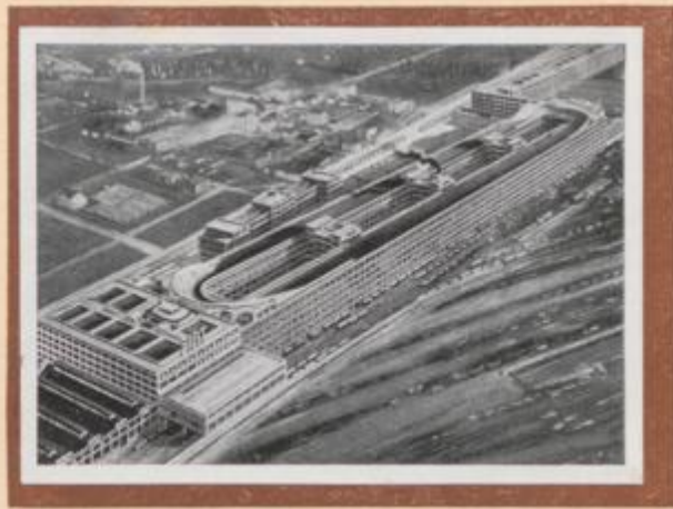
194 Vom Fließband aufs Dach. Über den ganzen Komplex der Fiat-Werke in Turin erstreckt sich kilometerlang die Rennbahn auf dem Dach zur Erprobung der Fabrikate.
