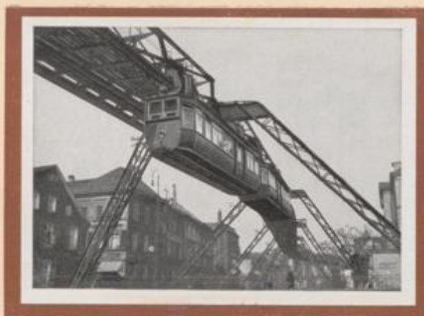
227 Wuppertalbahn. Langensche Schienen-Schwebebahn zwischen Elberfeld-Barmen. Stützgerüst aus Stahl, Wagen frei pendelnd an Schiene aufgehängt. Vorteil der Einschienenbahn: Herabsetzung der Reibungswiderstände. Nachteil: hoher Kostenaufwand für Traggerüste. Eröffnet 1903.
