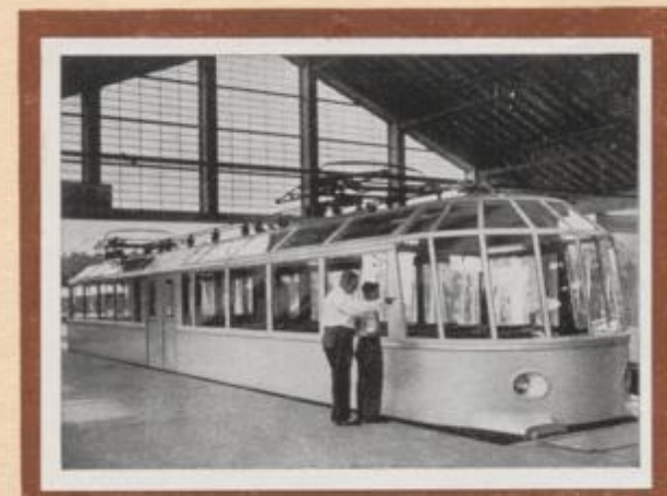
221 Aussicht-Triebwagen. Spezialkonstruktion der Reichsbahn von 1935. Elektromotor. Stromabnahme vom Fahrdrabt. Herabsetzung auf Maschinenspannung erfolgt durch Transformator.
