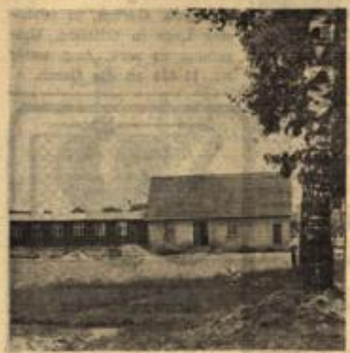
Altes Clubhaus und ehemalige Wirtschaftsbaracke des Arbeitsdienstlagers wurden zur neuen Sporthalle des Athletiksportvereins Urioffen vereint.
