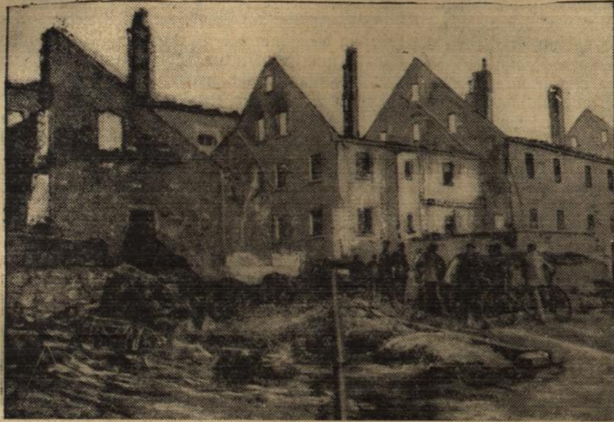
Der kleine Marktflecken Luhe in der Oberpfalz wurde von einem furchtbaren Schadenfeuer heimgesucht, dem 18 Wohnhäuser nebst Nebengebäuden und Scheunen zum Opfer fielen.
