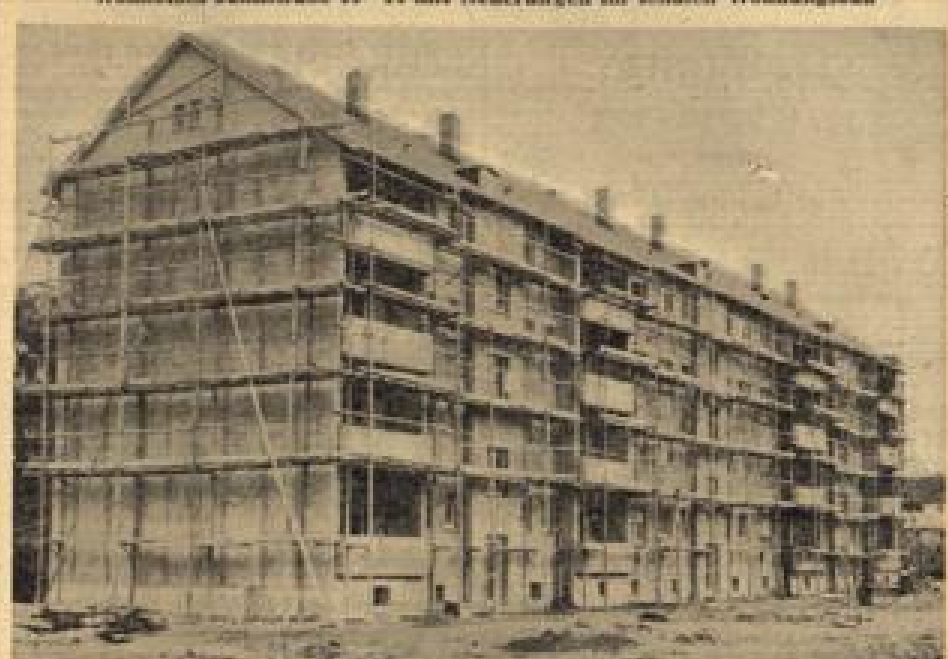
Obwohl die Gerüststangen noch bis in die oberen Stockwerke reichen, ist der neue Block in der Jahnstraße 10-14 seit einigen Tagen von den ersten Mietern bezogen worden.
