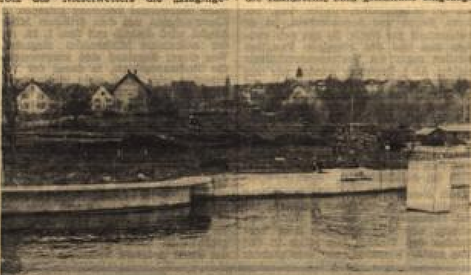
Das 8000 qm große Gelände am Ständer Fährhafen gleicht gerade in diesen Regentagen einem Morast, durch den sich die Planiertruppe (im Mittelgrund des Bildes) ratierend bewegt. Der Stellung muß abgeflacht werden, um das richtige Gefälle vom Ruppenerweg bis zu den Fährlandbrücken zu schaffen.
