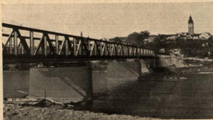
Ennsbrücke bei Enns.
