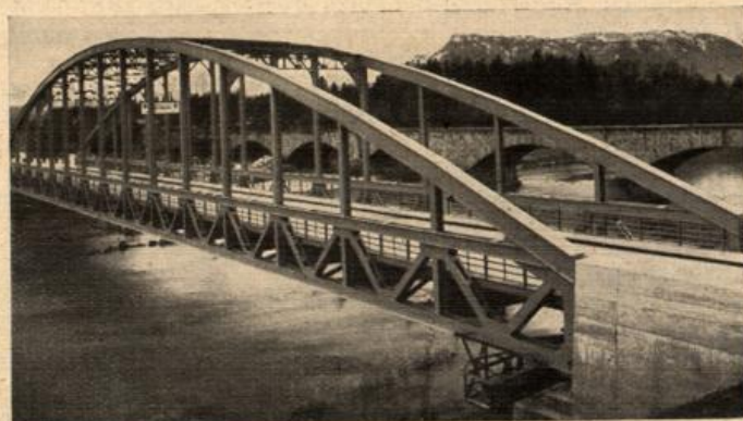
Saalbachbrücke bei Freilassing.
