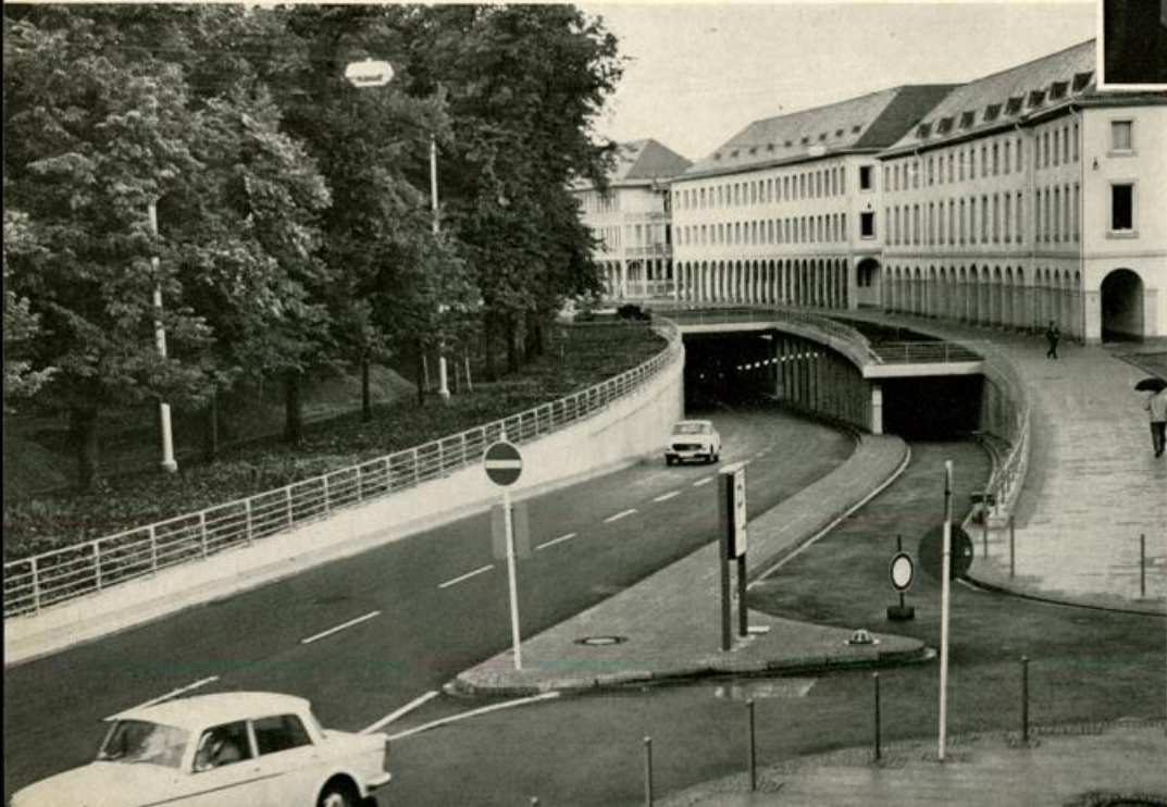
Tiefstraße am Schloßplatz
