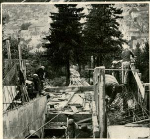
Umbau der Turmbergbahn
