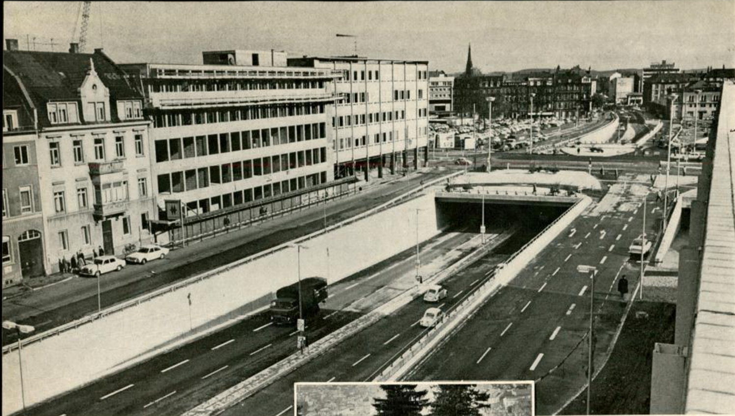
Unterführung am Ettlinger-Tor-Platz
