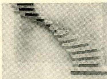
Freitragende Treppen mit stahlarmierten Trittplatten, aus allseitig geschliffenem Betonwerkstein, können in jeder gewünschten Variation in ein Gebäude, ob Alt- oder Neubau, ohne Beschädigung der Treppenhauswände eingebaut werden. Die gesamte Treppenanlage stellt ein selbsttragendes Bauelement dar.
