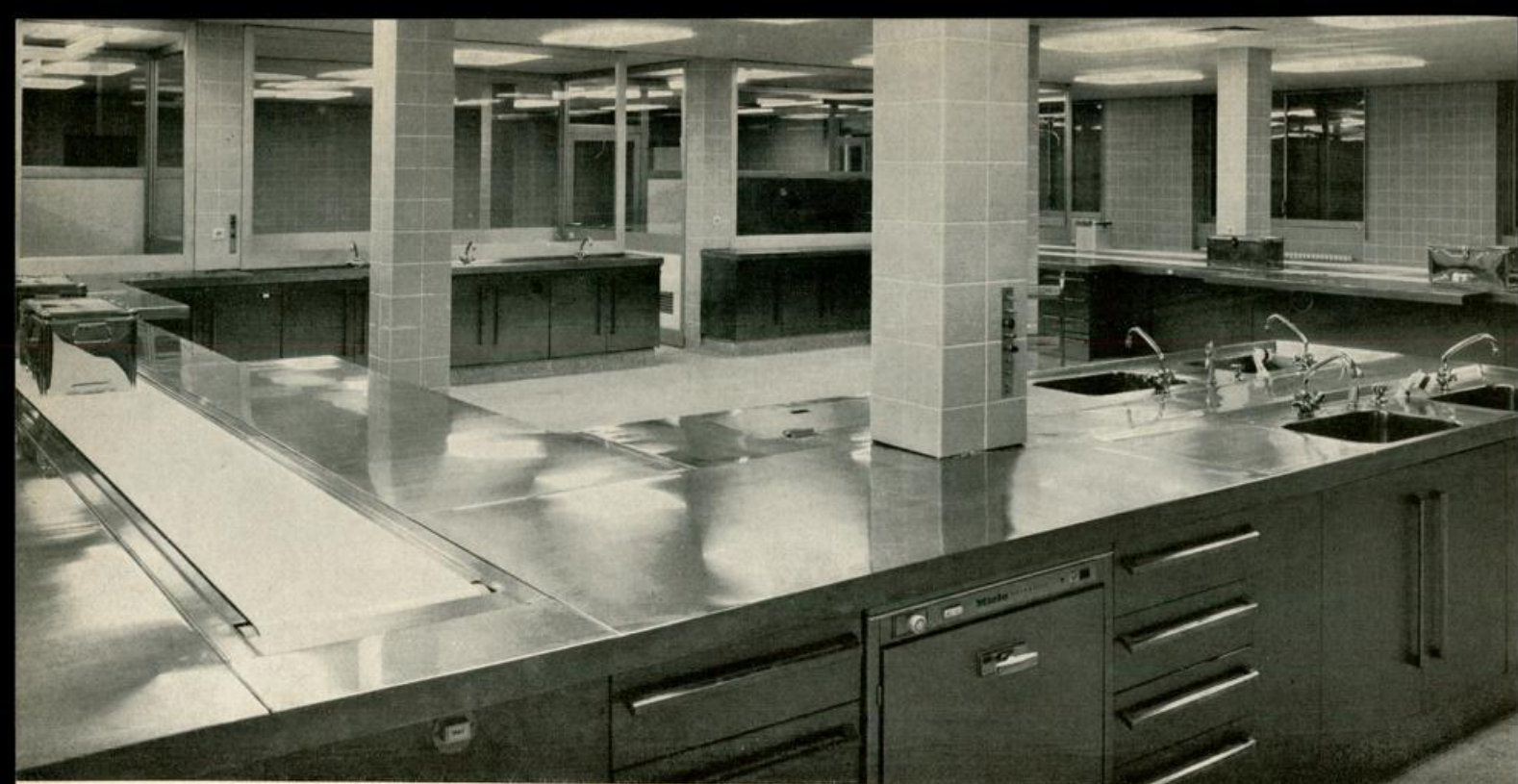
Blick in die unreine Seite der Zentralsterilisation
