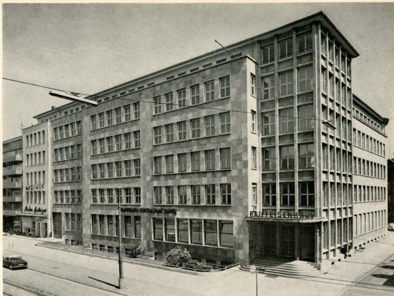
Das Raiffeisenhaus in Karlsruhe · Raiffeisenplatz
