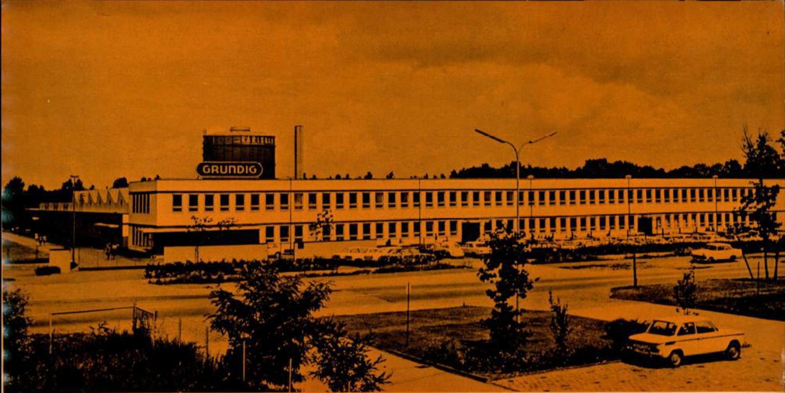
31 durchdacht: Von der Materialanlieferung bis zum Gleisanschluß an das Schienennetz der Bundesbahn verläuft der Produktionsvorgang auf nur einer Ebene mit jeweils kürzesten Transportwegen von Station zu Station. Neueste mechanische Fördereinrichtungen bedienen in einem bestimmten Takt fünf lange Montagebänder. Vor dem
