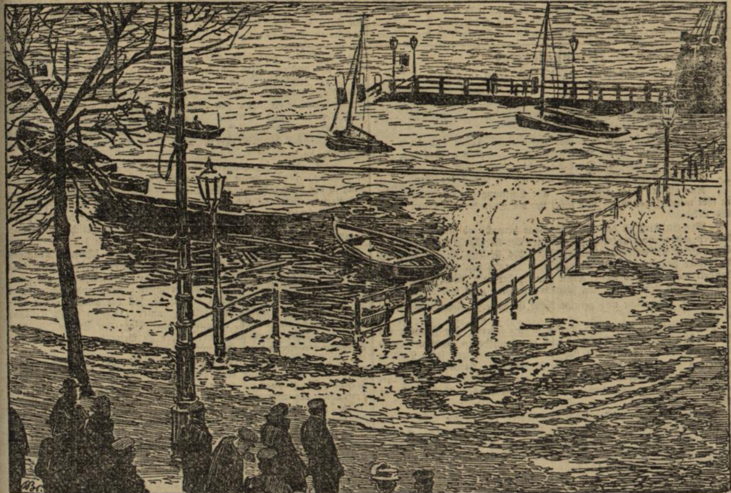
Die überschwemmte Schloßbrücke.
