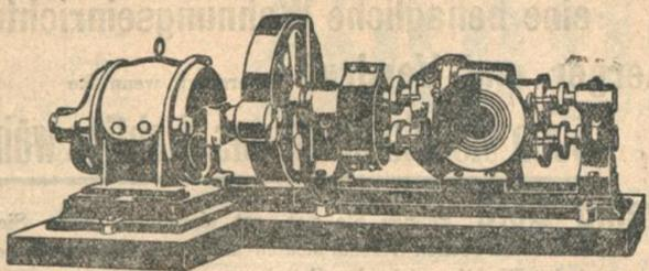
Rotierende Pumpe für direkten elektrischen Antrieb mittels Zahnradübertragung, zur Förderung von dicken und dünnen, kalten und heißen Flüssigkeiten bis zu 2000 Liter Leistung pro Minute.
