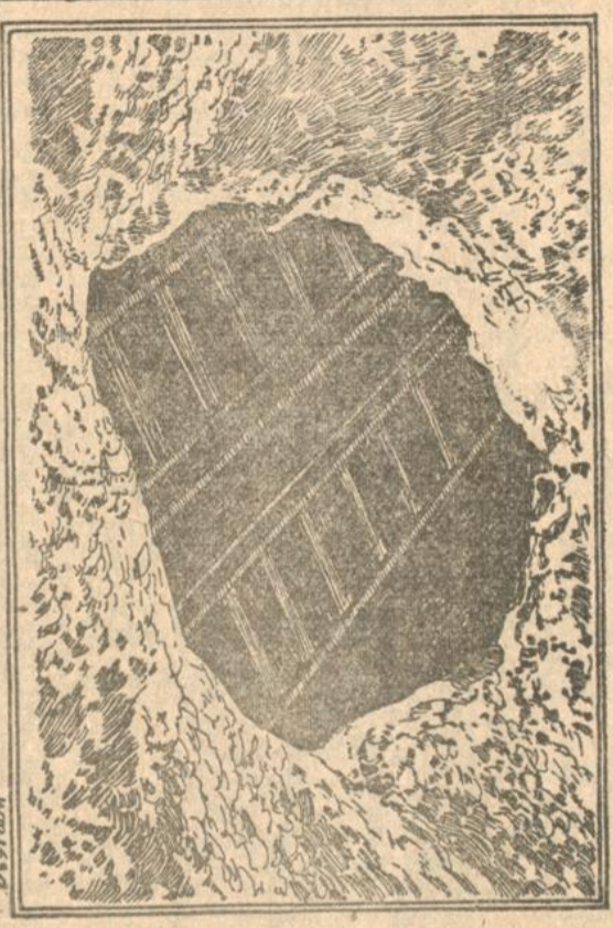
EXCAVATION DANS LA VOUTE DU METRO
