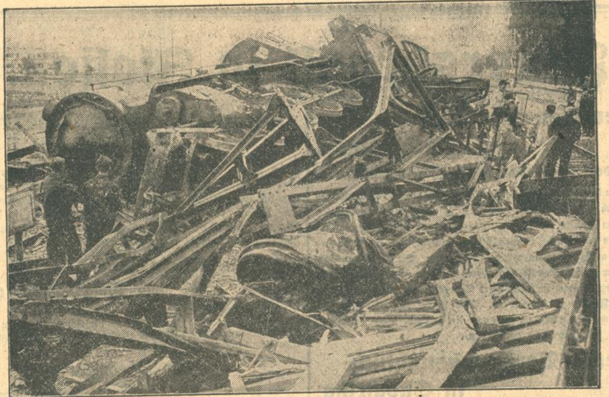
Der Trümmerhaufen vor der Lokomotive des aufgefahrenen beschleunigten Personenzuges.
