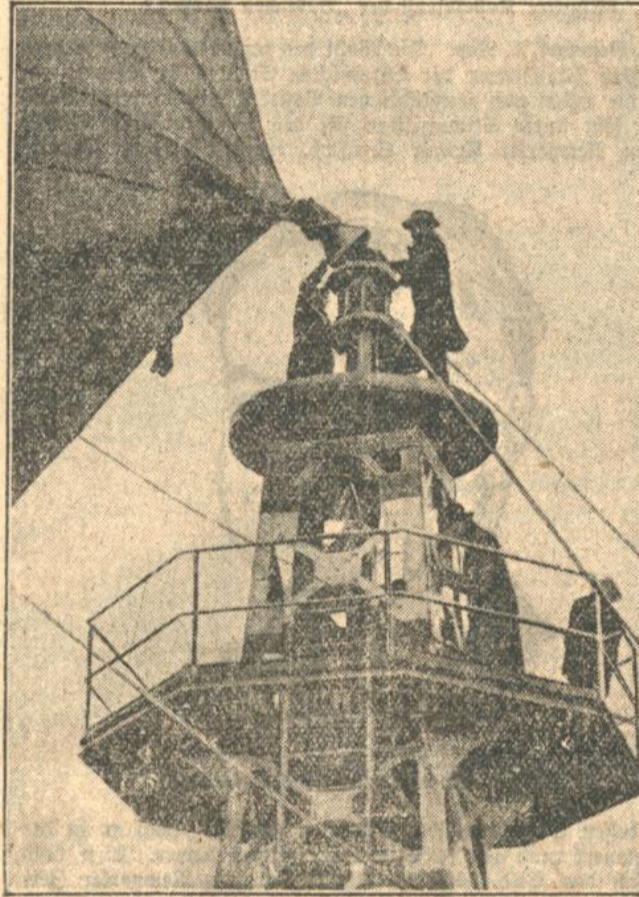
Das Fahrgestell (obenstehendes Bild), auf dem die hintere Motorengondel ruht, läßt das verankerte Luftschiff wie eine Wetterfahne sich gegen den Wind stellen.
