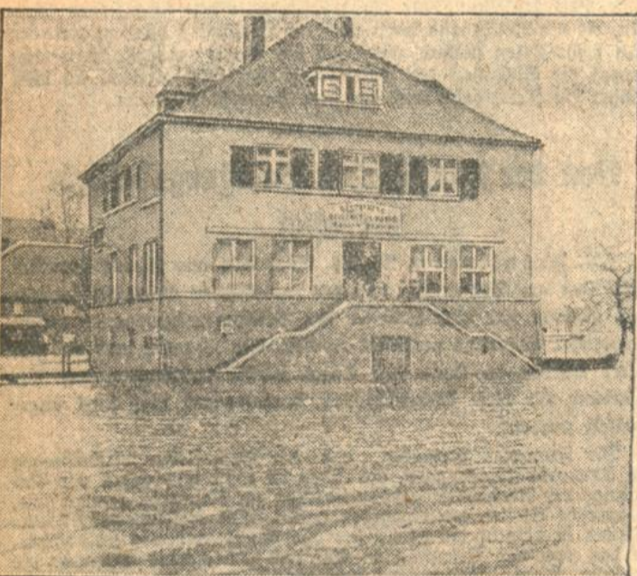
Infolge der ungewöhnlich starken Regenfälle, die das Anwetter der letzten Tage über Nord- und Westdeutschland brachte, ist die Ruhr über ihre Ufer getreten und hat die anliegenden Ländereien überschwemmt. Wir zeigen ein Haus in Essen, das wie eine Insel im Wasser liegt.
