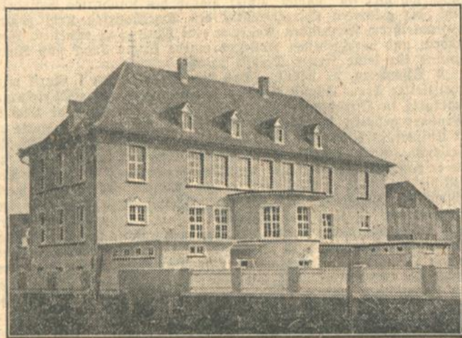
Das neue Schulgebäude in Willstätt.
