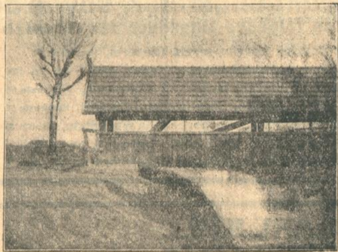
Die alte Albrücke.
