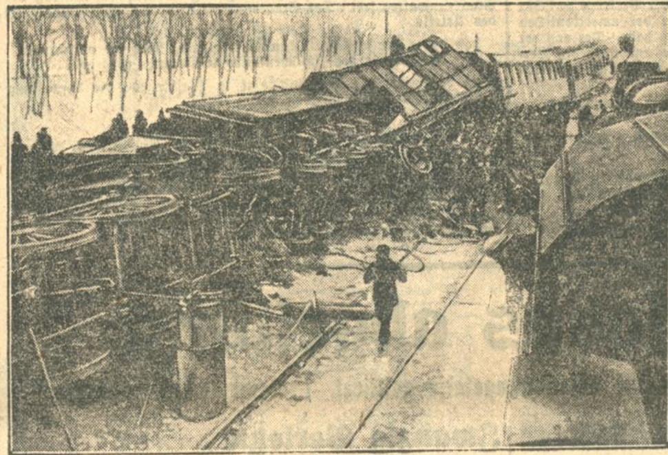
Durch Entgleisung des Schnellzuges Kischinew-Bukarest bei Boboc (unweit Buzau) wurden, wie berichtet, zwanzig Personen getötet und 65 verletzt. Die Aufräumarbeiten wurden durch einen Schneesturm sehr erschwert.
