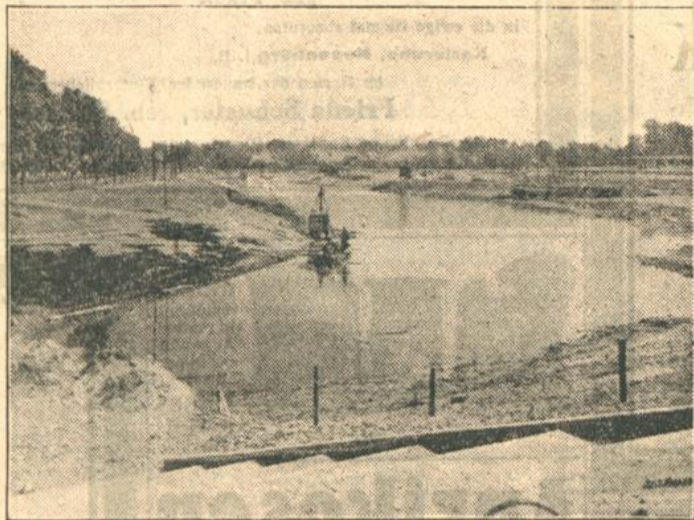
Das vor der Vollendung stehende Schwimmbecken.
