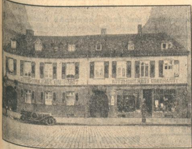
Das alte Gebäude.
