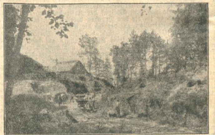
Durchbruch bei der „Friedrichshöhe“.
