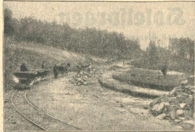
Ausbau einer Kurve.
