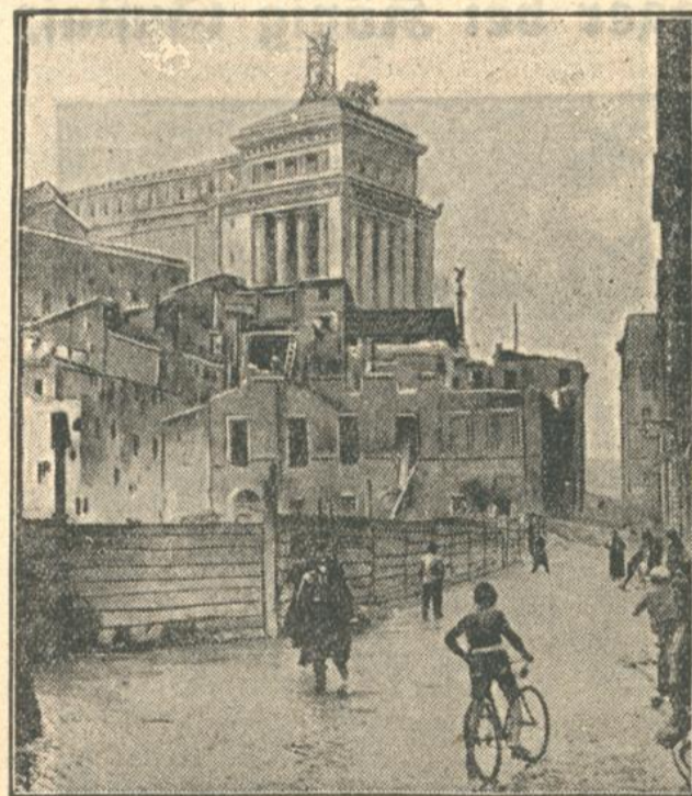
Auf Veranlassung Mussolinis wird durch das Forum Romano in Rom eine Straße gebaut, die durch die Entwicklung des Verkehrs in der Weltstadt notwendig wird. Bei den Bauarbeiten hat man viele interessante Ruinenentdeckungen gemacht, die man an anderer Stelle der Stadt wieder aufbauen will.
