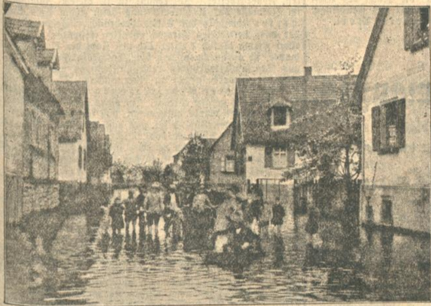
Staffort: Die Bruchstraße unter Wasser.
