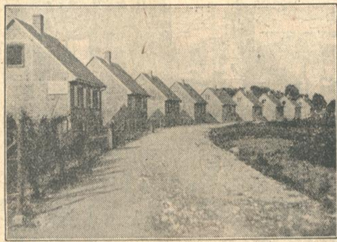
Straße der Kehler Vorstadt-Siedlung.
