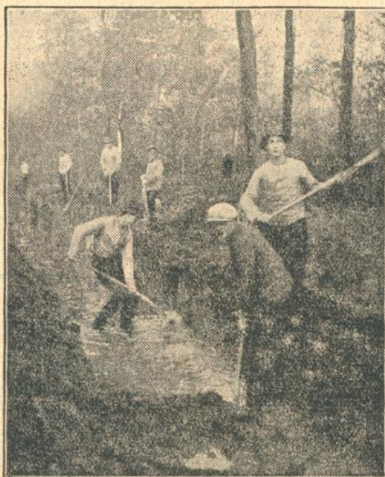
Bei der Kanalisierung in Kastenwört.
