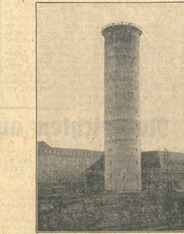
Der Wasserturm der klinischen Anstalten.
