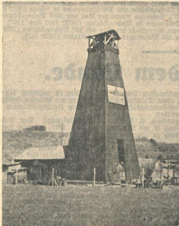
Der Bohrturm bei Zahr wird abgebrochen.
