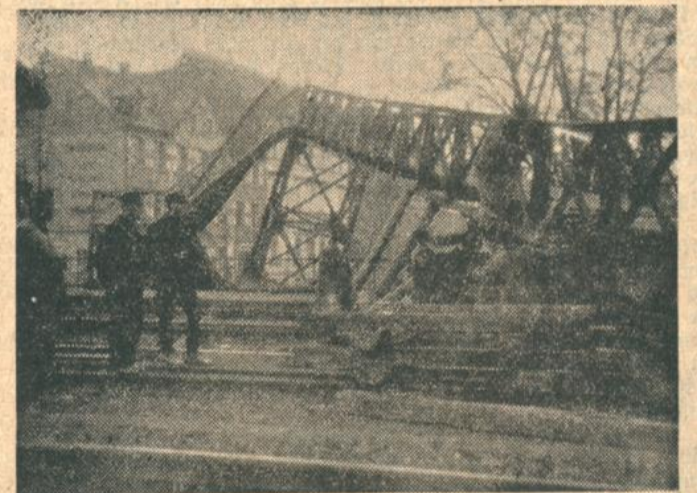
Der niedergerillene Personenübergang im Brudhaler Bahnhof.
