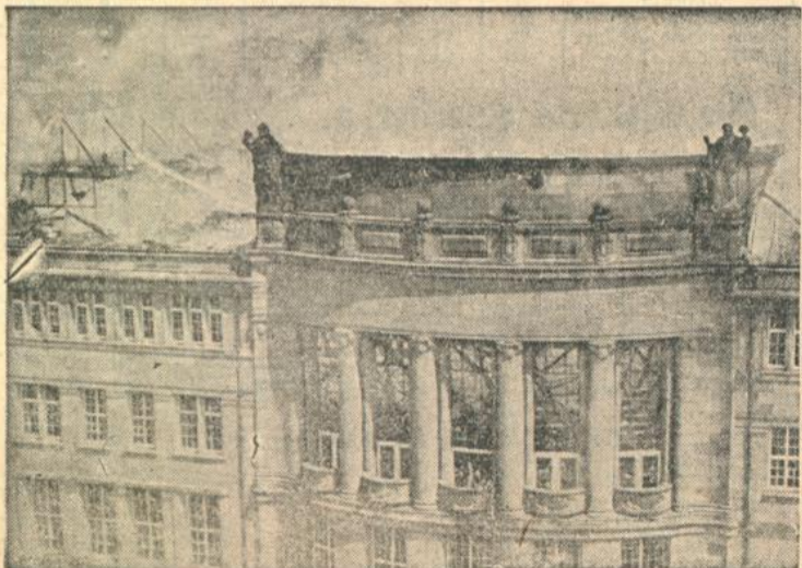
Die Kuppel ist eingestürzt.
