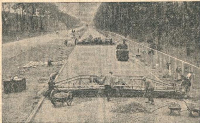
Straßenfertiger bei Teerbetonarbeiten auf der Berliner Avus.
