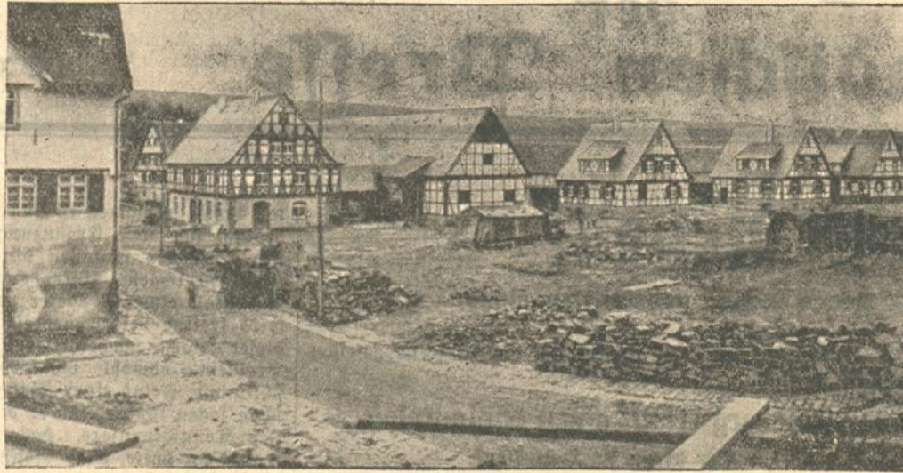
Die schönen Fachwerkbauten im neuen Döschelbronn.
