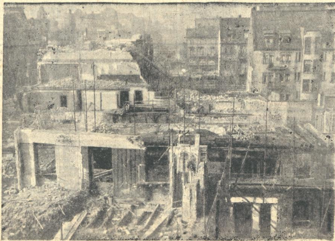
Die Abbrucharbeiten sind heute beendet
