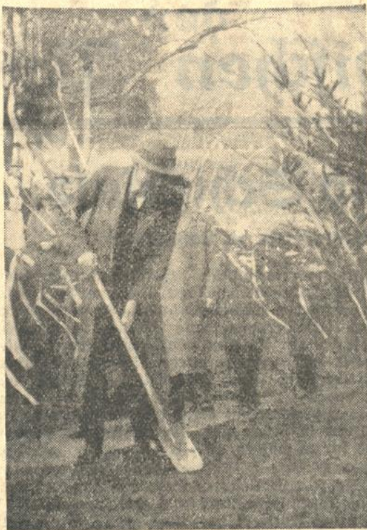
Oberbürgermeister Schwedhelm beim ersten Spatenstich zum Bau der neuen Spielbank.
