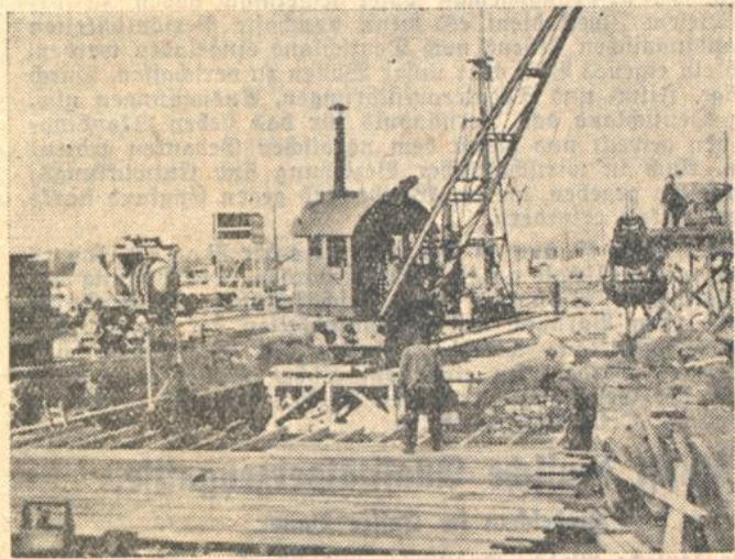
Blick auf die Baustelle am badischen Ufer.
