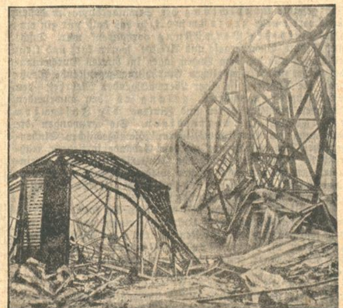
Die eingestürzte Seitenhalle in der belgischen Abteilung auf dem Gelände der Weltausstellung 1935 in Brüssel. Die Halle stürzte während der Bauarbeiten ein und begrub etwa 40 Arbeiter unter sich. Das Unglück hat bekanntlich 8 Todesopfer gefordert, 21 Arbeiter sind verletzt.
