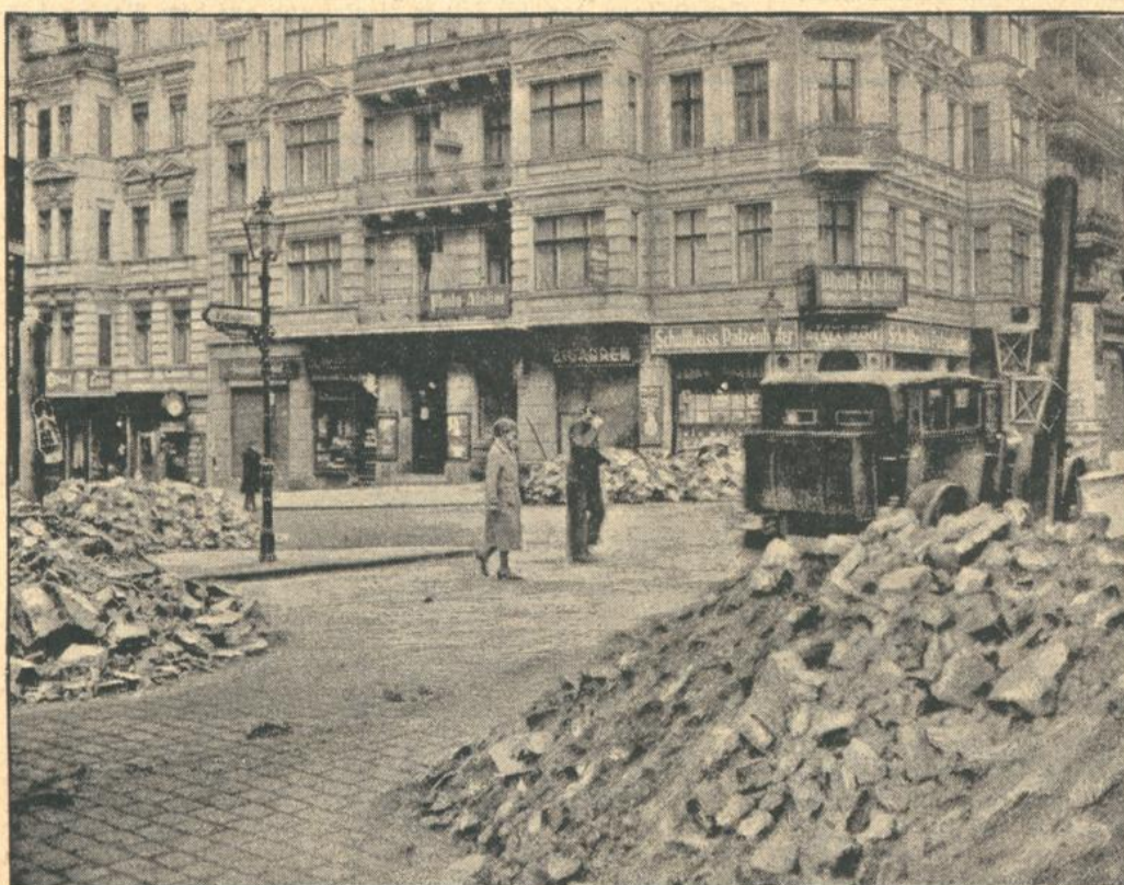
Berliner Straßen im Kreuzbergviertel bei der großen Luftschutzübung. Angefahrener Schutt, der nur noch einen engen Spalt auf der Fahrbahn freiläßt, und während der Übung die Straße völlig versperrte, markiert die Trümmer der durch „Bombeneinschläge zerstörten Häuser“.
