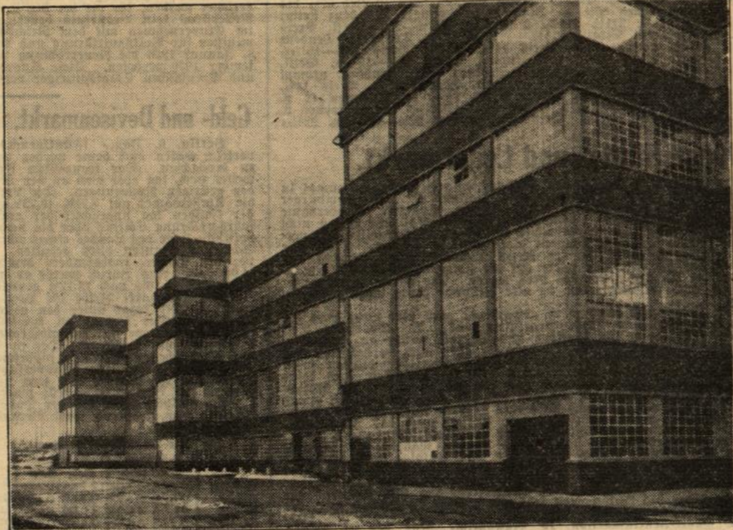
Nordwestlich von Brandenburg erheben sich aus 340 Morgen großem Fabrikgelände die Fronten: die Haupthalle bedeckt mit 178 Meter Länge und 136 Meter Breite etwa 10 Morgen Bodenfläche. Photo: Opel.
