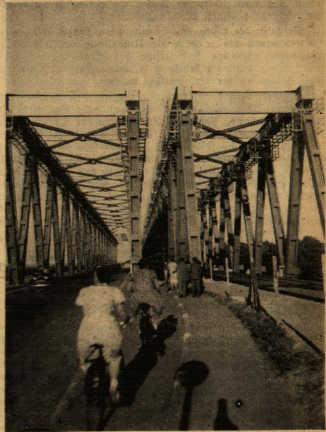
Von Karlsruhe a. Rh. führt die neue Rheinbrücke in die Pfalz
