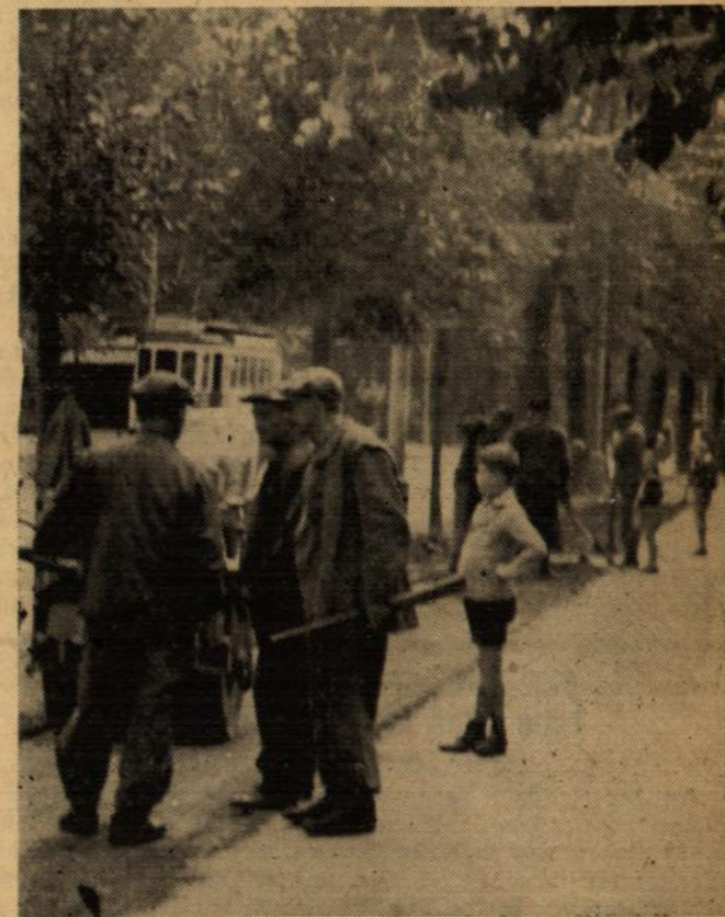
Der Ausbau der restlichen Strecke am Vierordtbad
