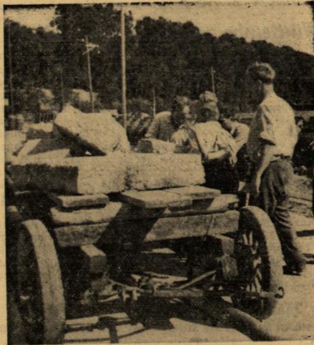
Auf stämmigen Wagen werden die Quadersteine zum Brückenbau transportiert
