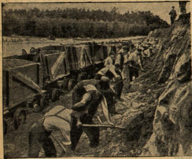
Das abschüssige Gelände erfordert besondere Planierungsarbeiten
