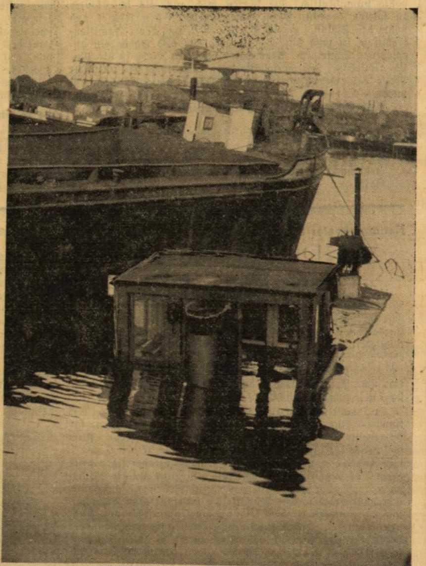
Vom abgesackten Schiff ragen nur noch die Aufbauten halb aus dem Wasser
