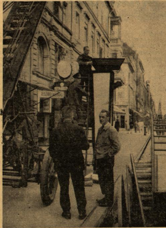
Die Leuchtsäulen werden aufgestellt
