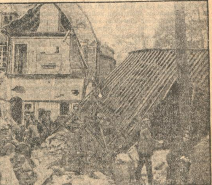
Die schwerbeschädigte Villa mit den rechtsliegenden Dachresten des in die Luft geflogenen Anbaues.
